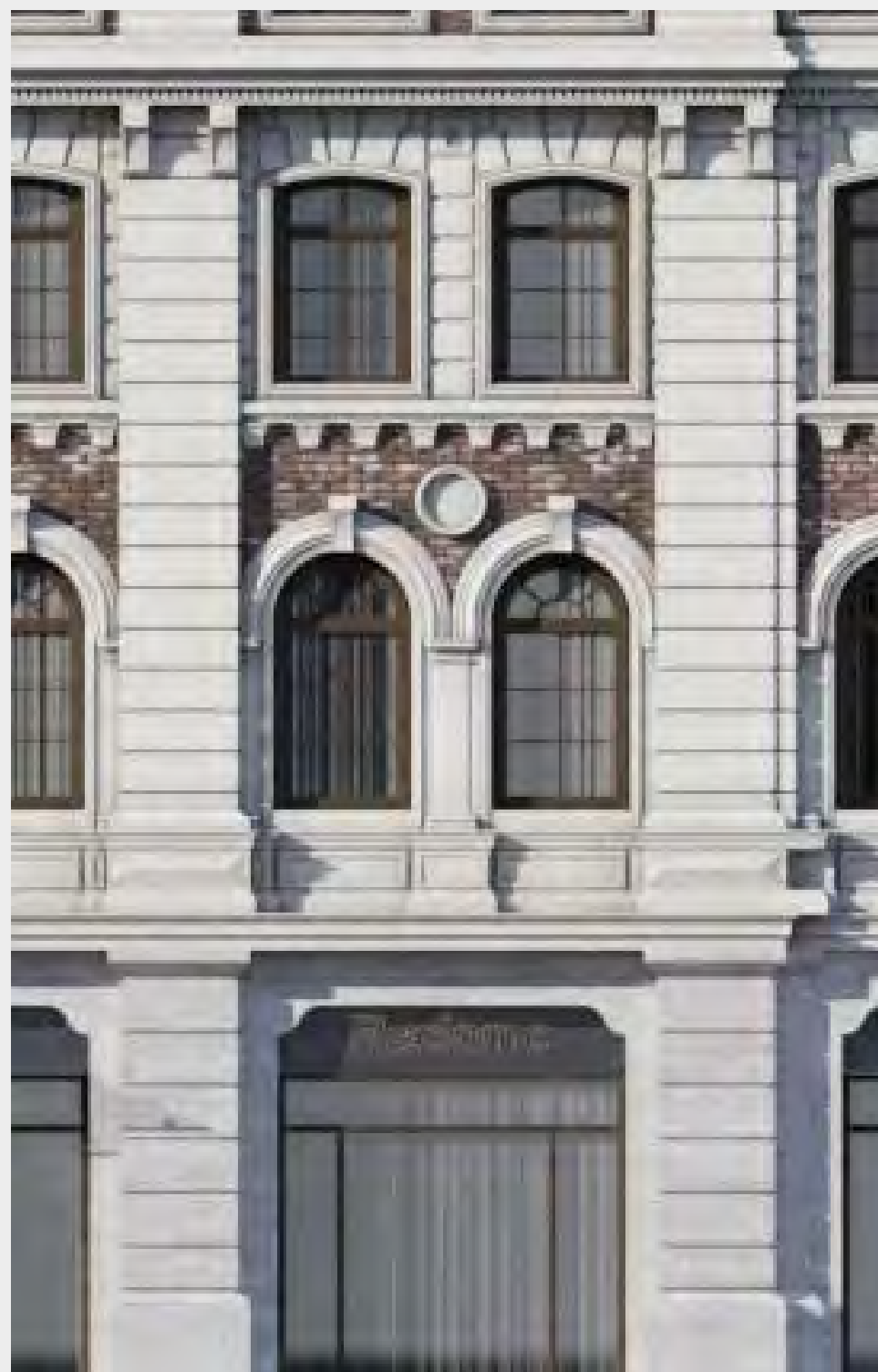
Окна исторический фасад
